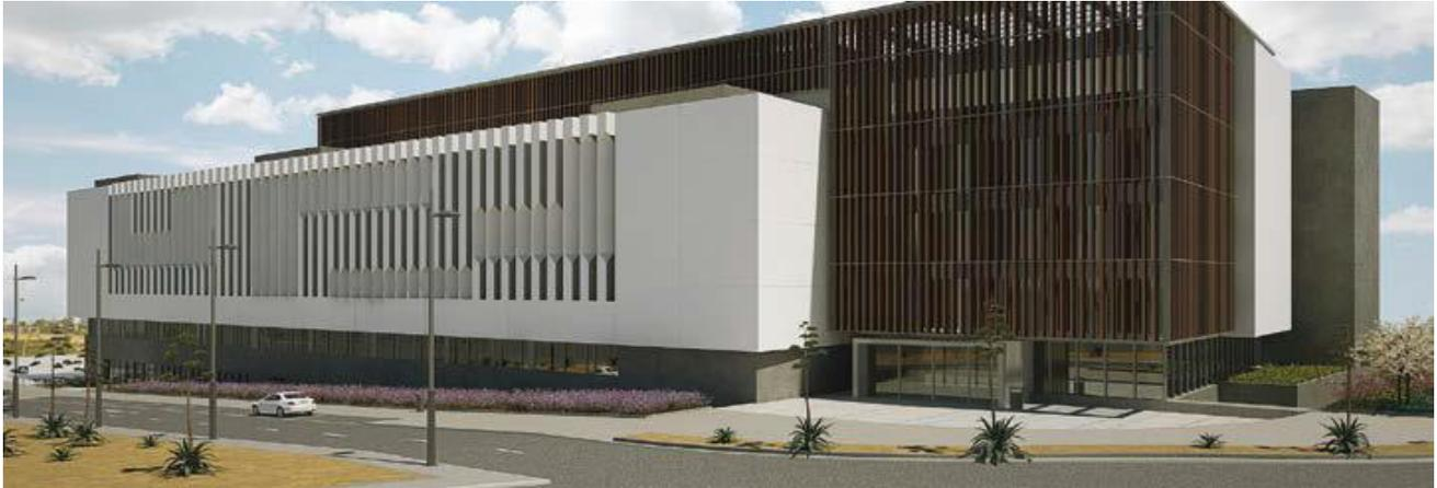
En la construcción de la envolvente de este edificio se han dispuesto elementos para contribuir a una mejor eficiencia energética, como la doble puerta de entrada, la carpintería con rotura de puente térmico, la fachada ventilada y la cubierta ajardinada. Se ha mejorado el aislamiento por encima de las exigencias del Código Técnico de la Edificación.
